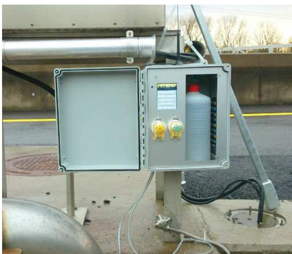
Abbildung 3: Installation eines SAK-254-436 Prototyps in der Kläranlage GAV Krens.
